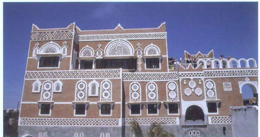
Die Südansicht des Hauptgebäudes des Jemen-Pavillons
