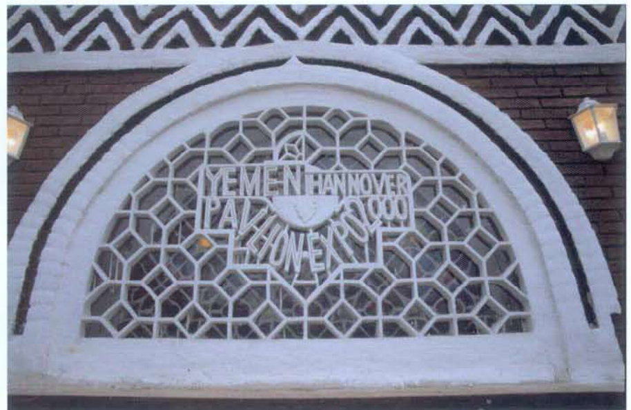
Das Emblem des Jemen-Pavillons im Oberfenster des großen Mafradsch
