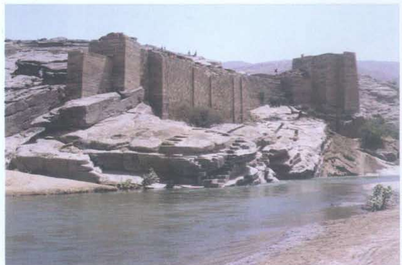
An der Südschleuse des sabäischen Staudammes
